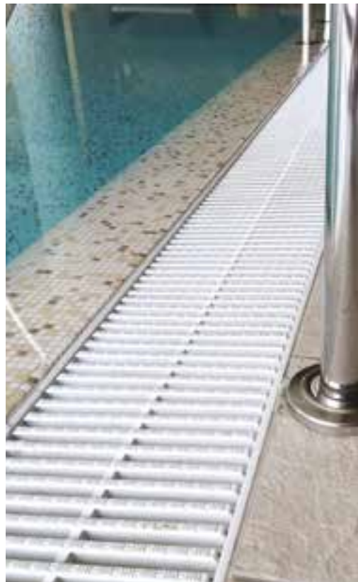
HO. POOL Finnisches System mit PVC - Abdeckung
