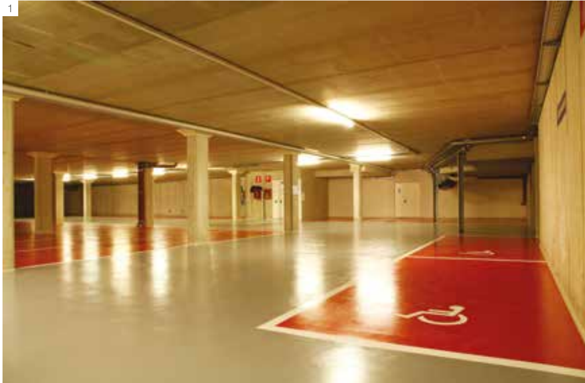
1 HO. BESCHICHTUNG Industriebeschichtung mit Markierungen
